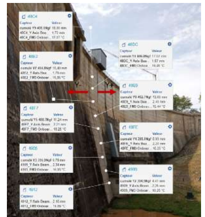
Simon-e® - Instrumentation d'un barrage
