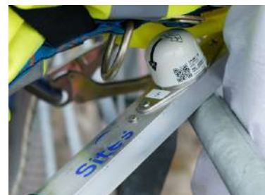
Installation d'un inclinomètre Senceive couplé à Simon-e®.
